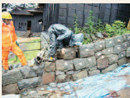
復元が進む京口千人溜り芦ノ湖側石垣
