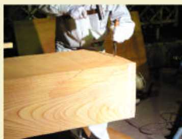
ひかり付けを行うため、柱の底を削ります
