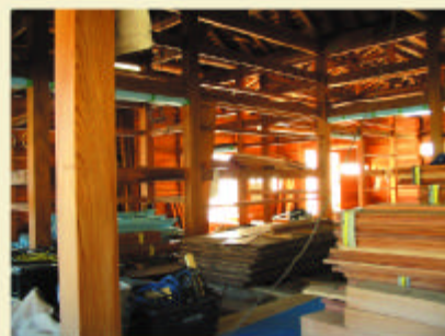
内部の仕上げ工事も順調に進んでいます
