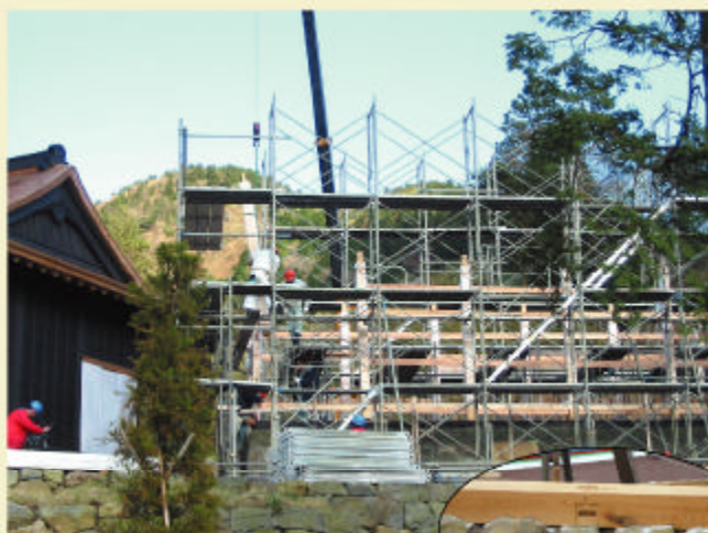
厩の柱の設置工事
