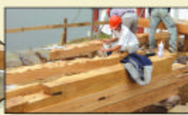
礎石の据え付け(ひかり付け)
